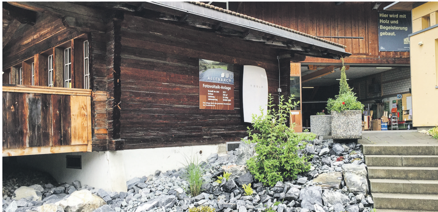
Holzbau und Installation von Solarpanels aus einer Hand – damit lassen sich auch bei bestehenden Bauten moderne Lösungen realisieren.
