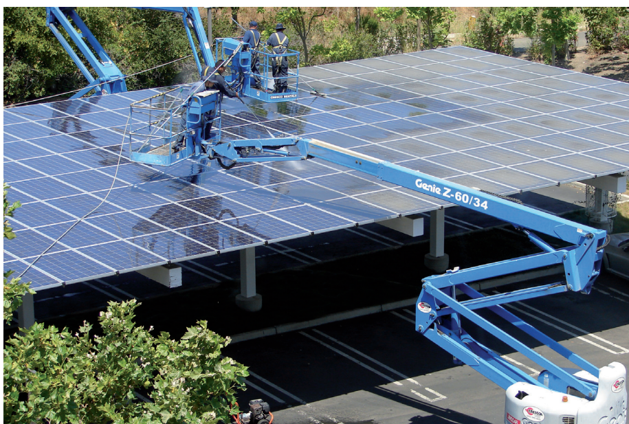
Reinigung Solarpanels auf einem Carport. Foto: Avinash Kaushik, via Wikimedia Commons, CC-BY-2.0
